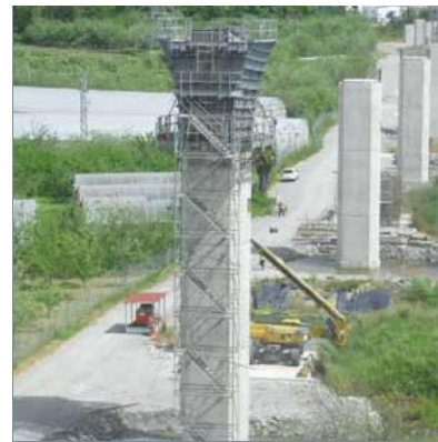
Columna de Puente
