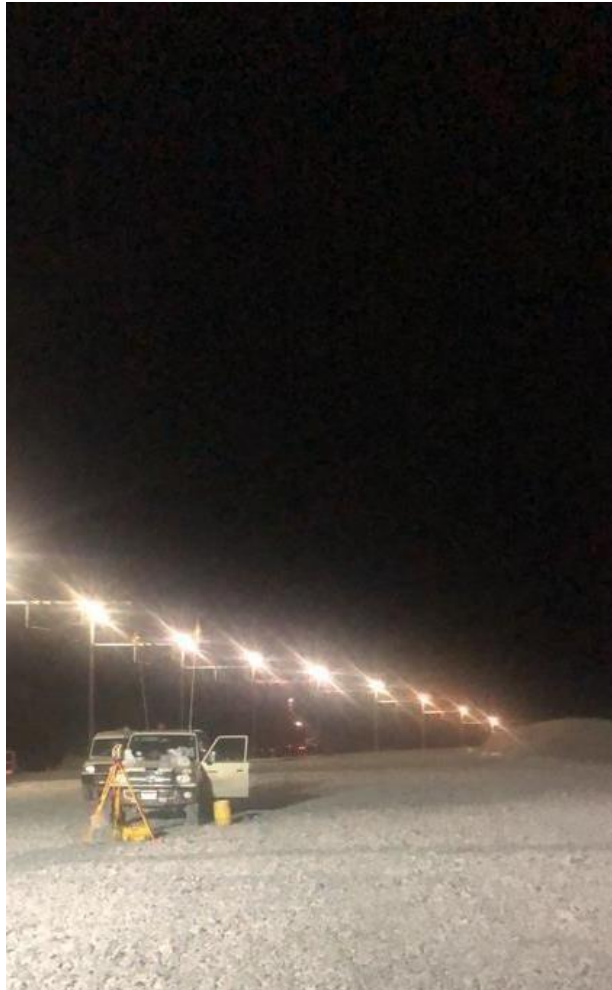
Figura 15. Trabajos nocturnos de instalación de nuevo Trolling en PIT
