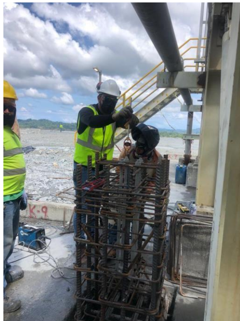
Figura 6. Replanteo de pernos
