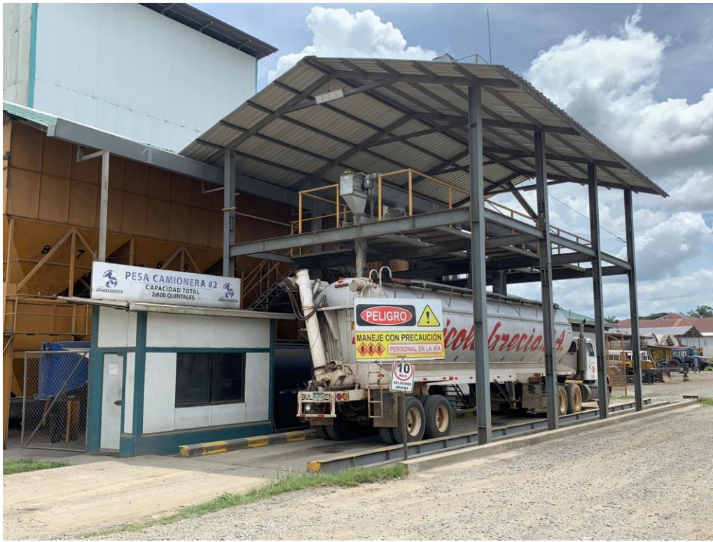
Anexo 6: Área de despacho del alimento terminado
