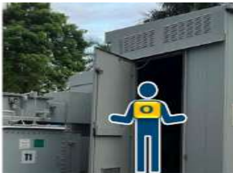
Tomado de Ingreso a la sala de media tensión , Informe charla de seguridad mes julio 2022, 2022, Distribuidora eléctrica
