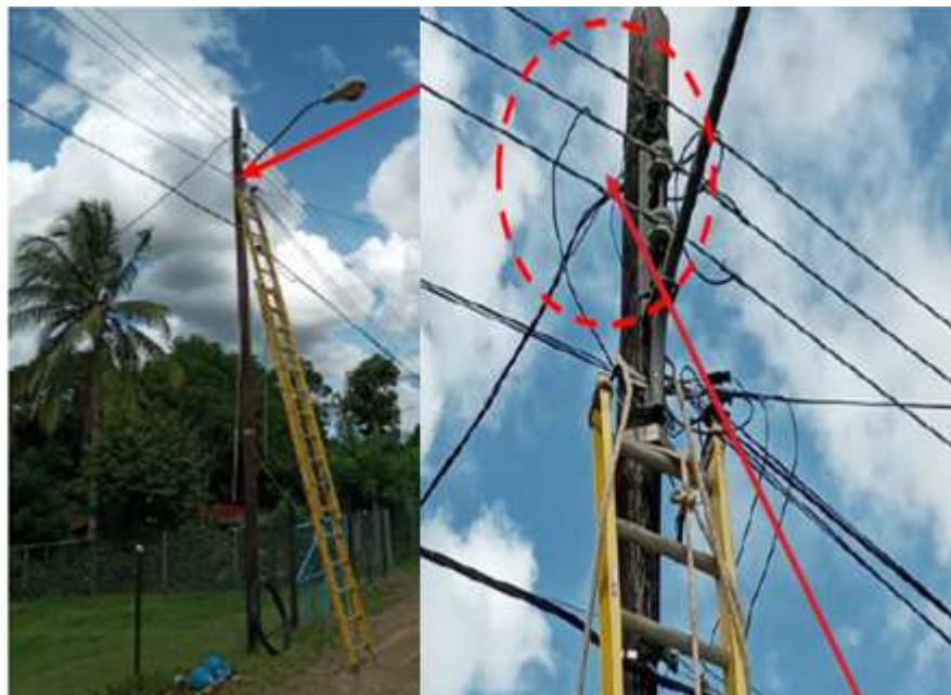
Tomado de Poste para el anclaje de la nueva línea de baja tensión secundario abierto Informe de charla de seguridad junio 2020, 2020, Distribuidora eléctrica
