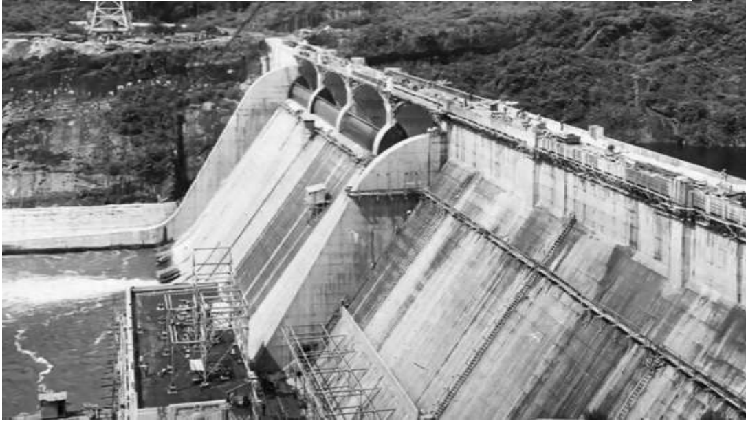
Figura No. 1 Central Hidroeléctrica Madden-Canal de Panamá
