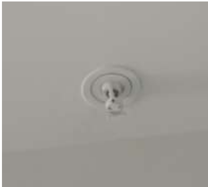
Figura 43 Sistema contra incendios, rociadores (NFPA 13).
