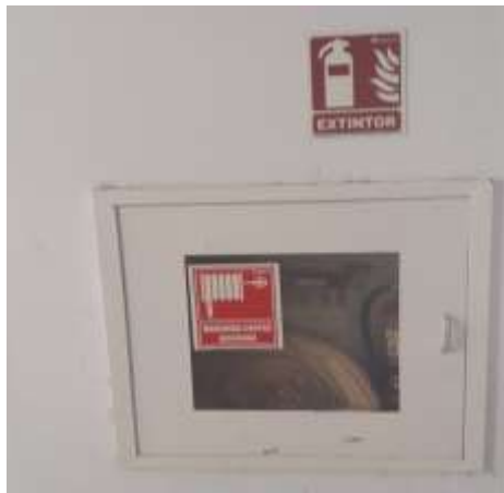
Figura 38 Manguera contra incendios, norma (NFPA-14).
