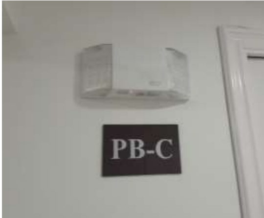
Figura 52 Lámparas de emergencias, norma (ART. 7.9 – NFPA 101).
