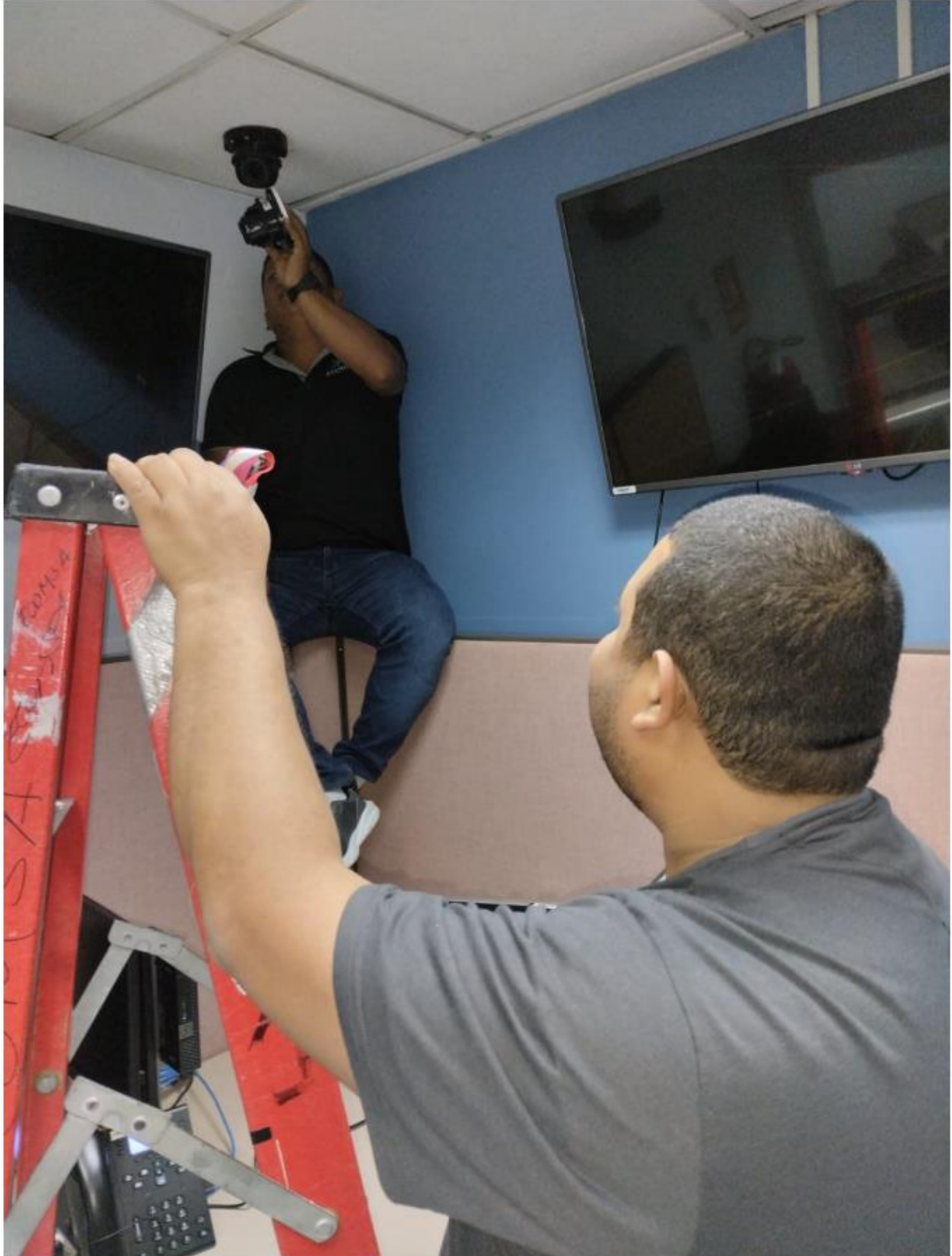
Ilustración 21: Reemplazo de cámara en el IT ROOM Sitio alterno
