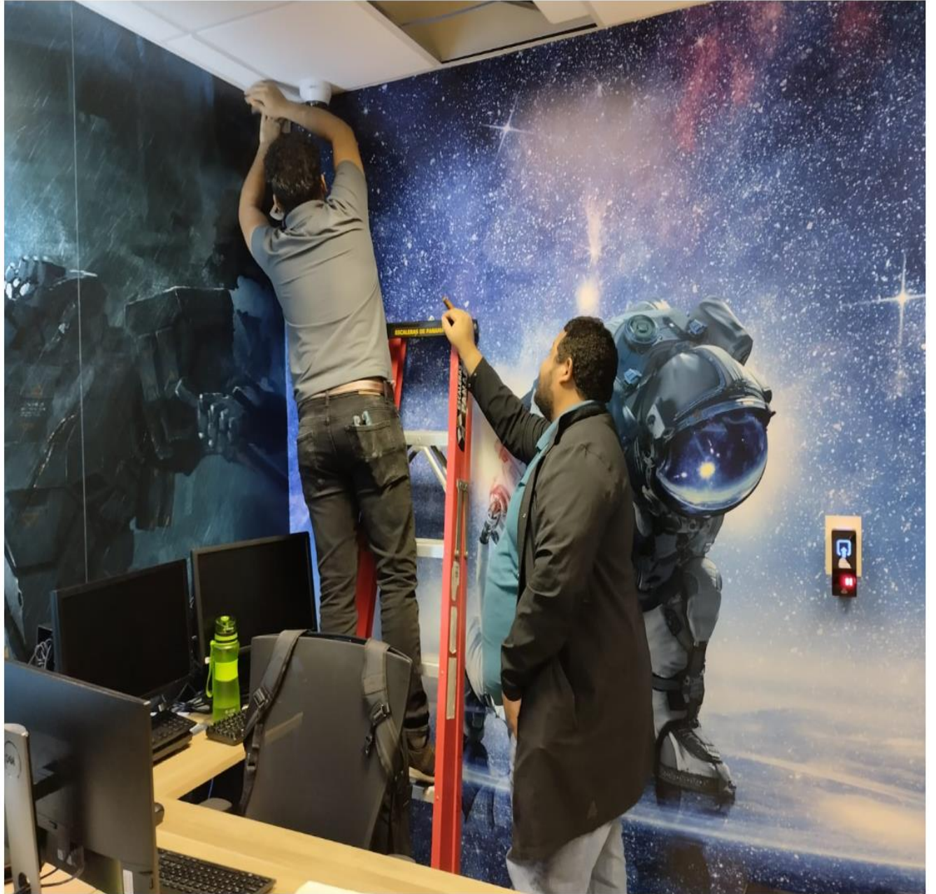
Ilustración 20: Instalación con el proveedor.
