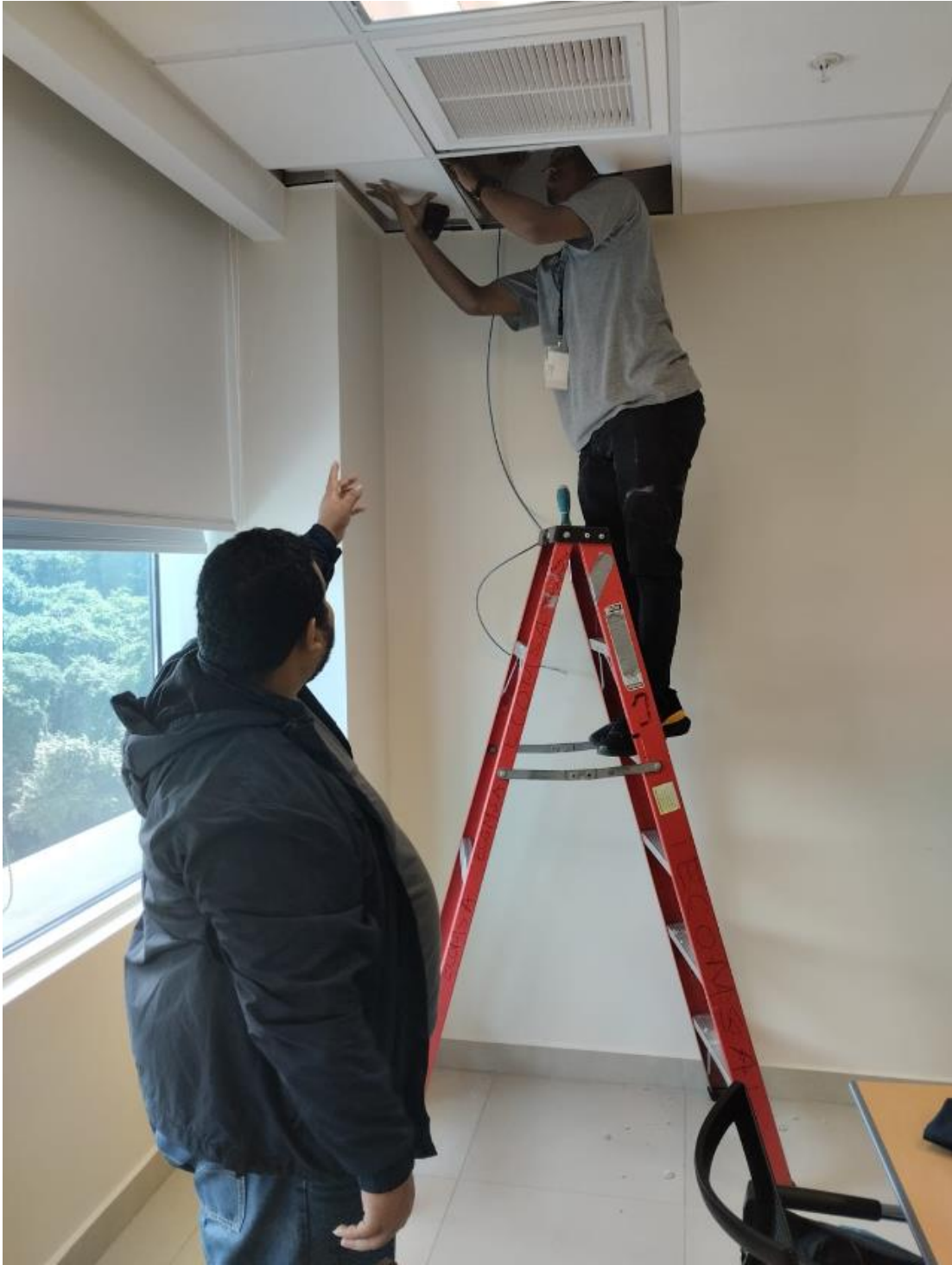
Ilustración 19: Instalación de cámara.
