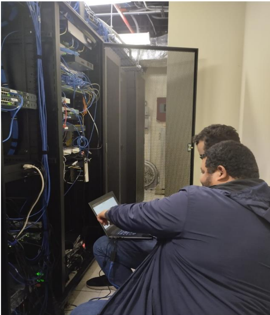
Ilustración 17: Configuración de la cámara en el servidor del NVR
