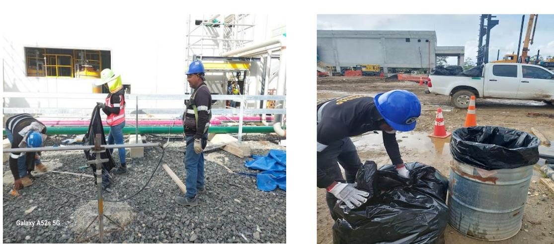
**Figura N° 17: Instalación de rotulo en altura e inspección visual de máquina de soldar. Fuente: autoría propia.**
