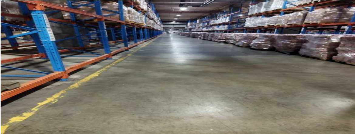
Figura 25 Líneas De Seguridad Borrosas.
