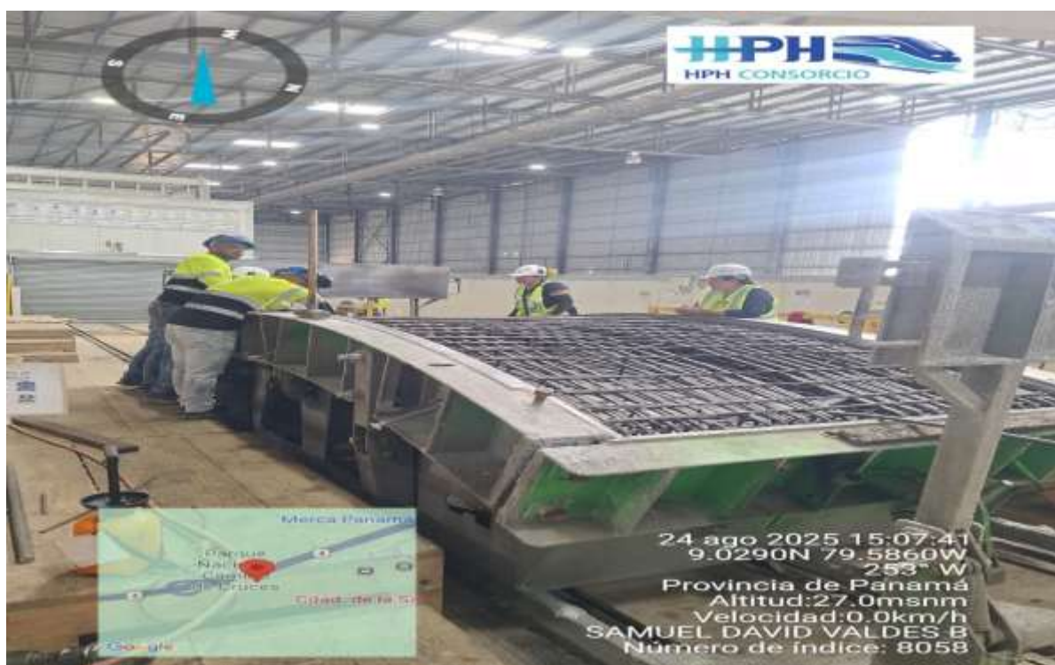
Figura 30. Durante la semana se realizaron medición en los moldes y se verifico el tema implementación de nuevo acceso a los moldes previo instalación las ferrallas de acero. (Autoría propia)
