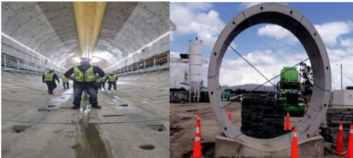
Figura 5 y 6. Fotografías de túnel de L3 poso de ataque y anillo de dovelas (propia Autoría)
