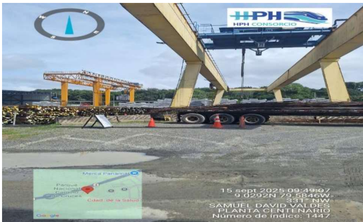
Figura 57. En inspección semanal al patio de la obra se pudo verificar la señalización, así como puntos a mejorar en los estacionamientos de camiones.
