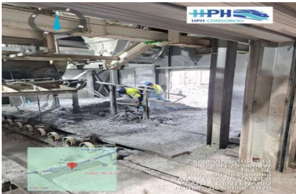
Figura 44. Se mantiene la inspección en el área de cabina de vaciado de concreto con el fin de garantizar que se realicen limpieza en cada jornada laboral. (Autoría propia)
