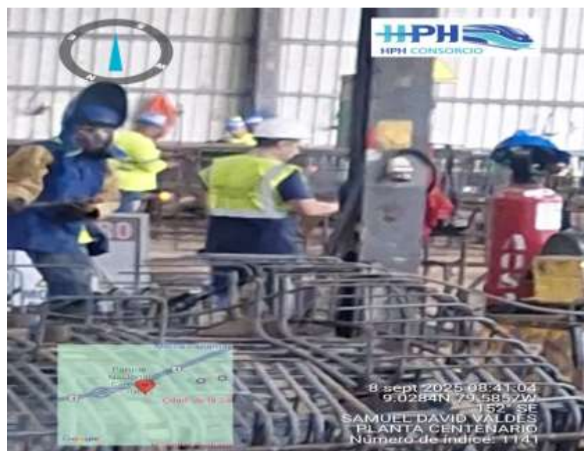
Figura 46. En inspección se encontraron desvíos en las zonas y los mismos se evidenciaron en reuniones a fin de garantizar que el mismo sea subsanado. (Autoría propia)
