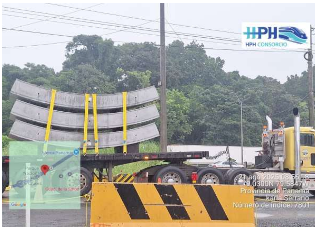
Figura 22. Se realizó inspección a los camiones que transportan dovelas hacia el área de túnel en zona de farfán. (Autoría propia)
