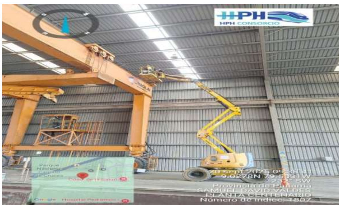
Figura 69. Parte de la inspección de la grúa CIMOLAIN(Autoría propia)
