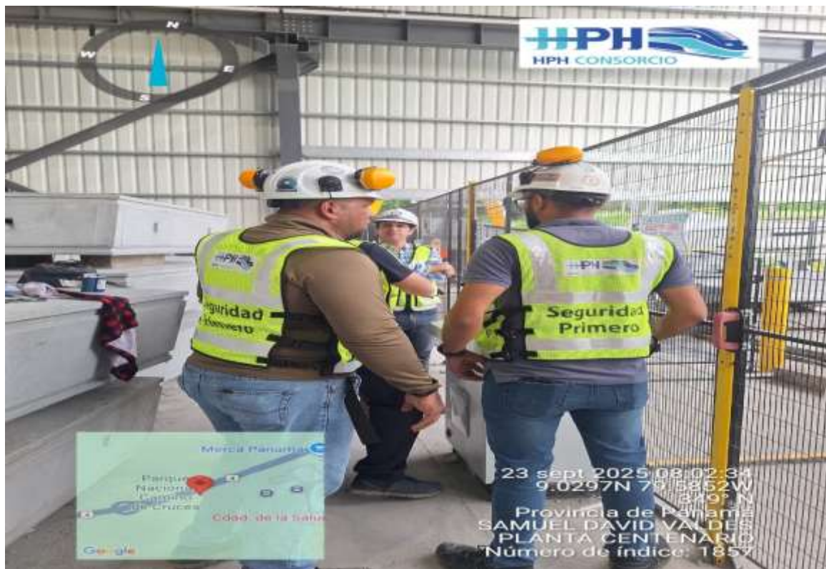
Figura 88. Revisión de equipos por mantenimiento de obra área de volteadora de dovelas. (Autoría propia)
