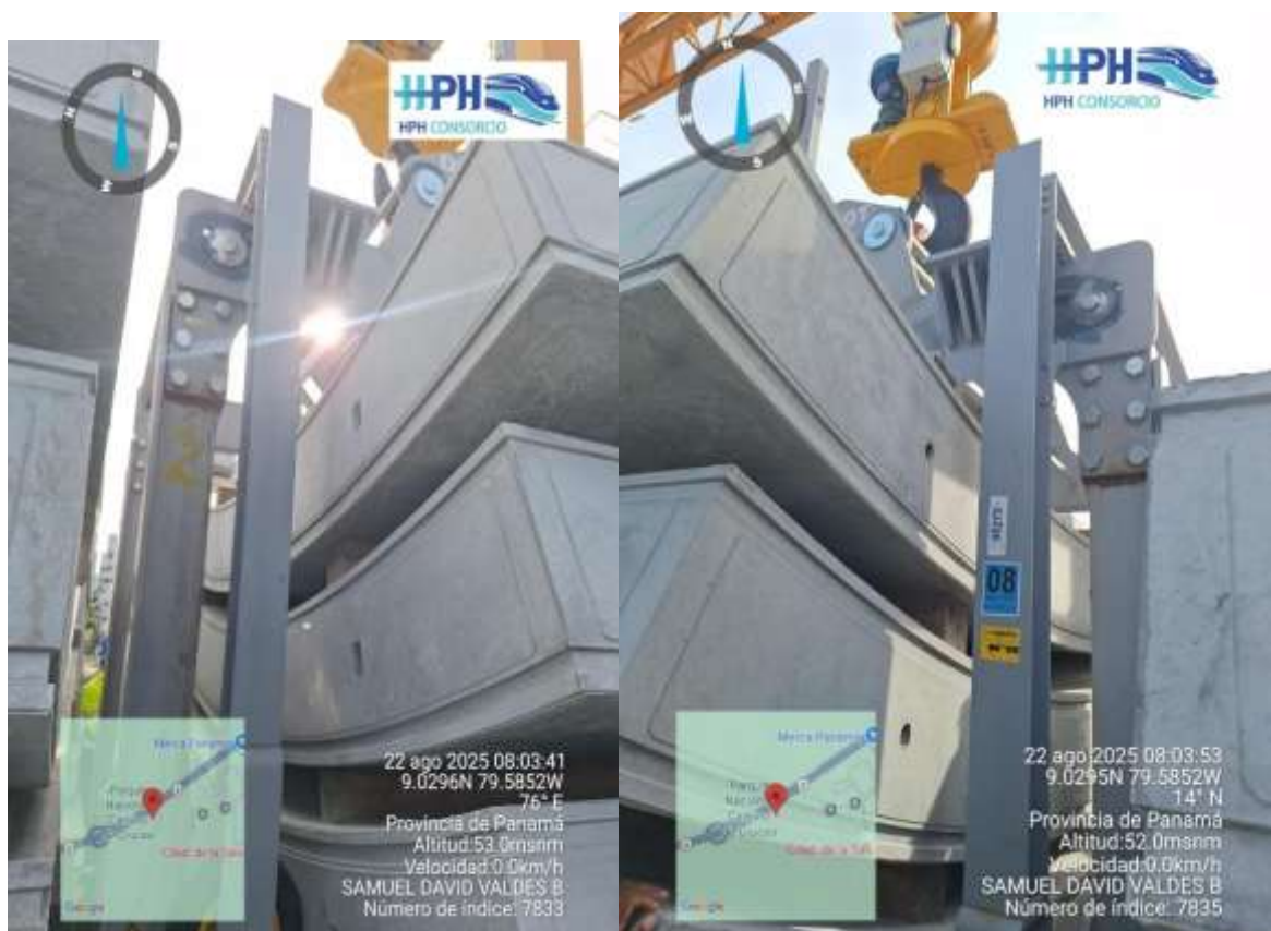
Figura 26. Se realizó Preinspección a los clanes o garras para izajes de dovelas en los mismos no se encontró ningún hallazgo significativo. (Autoría propia)
