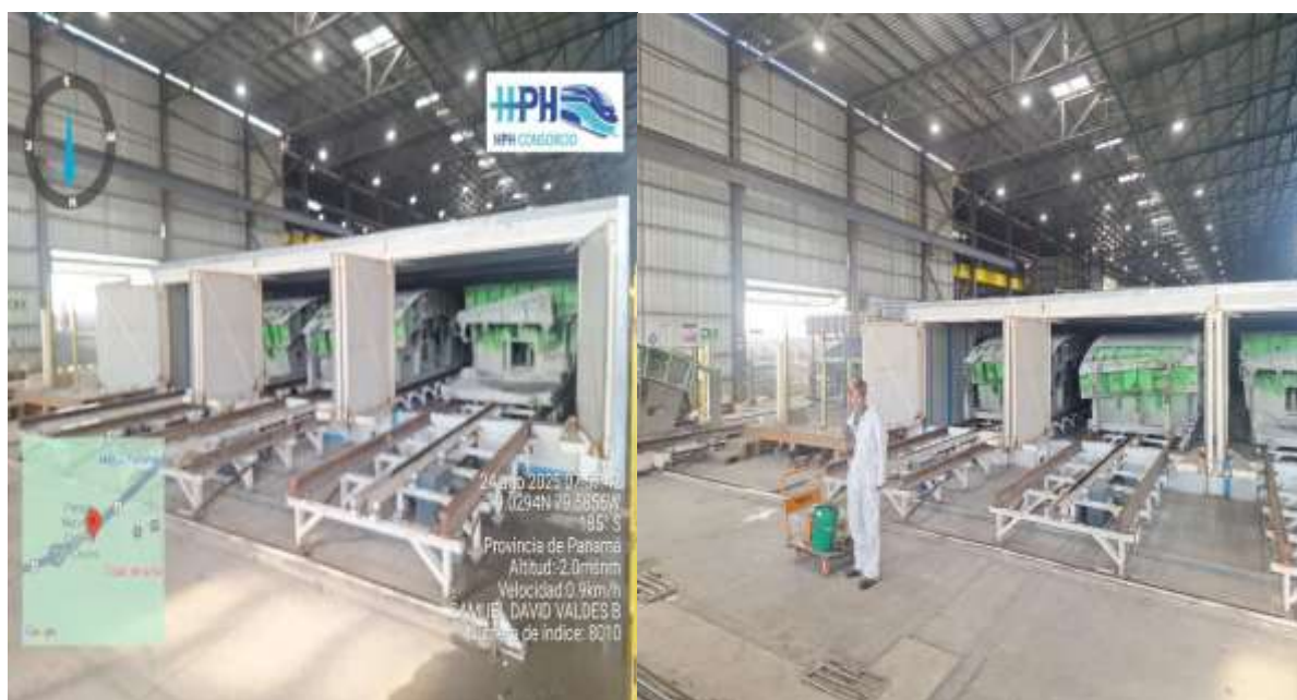
Figura 29. Se realiza inspección previa a las entradas en los moldes esto debido a que los mismos se consideran un espacio confinado y se deben mantener más procesos para su ingreso a esta zona. (Autoría propia)
