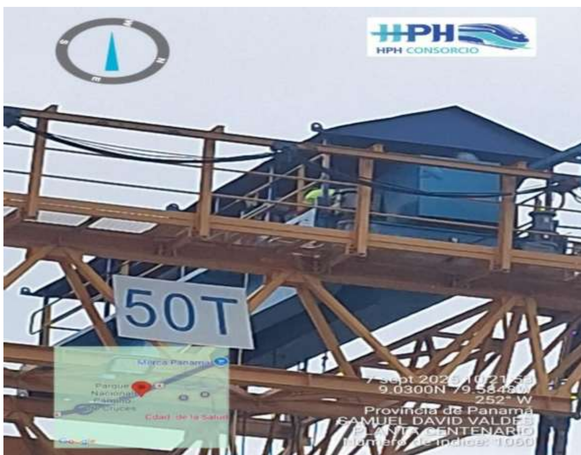
Figura 43. Me toco inspeccionar las grúas porticas de 50 la misma se inspecciona todos los meses y por consiguiente se tenía que verificar con mecánicas la inspección de la misma. (Autoría propia)
