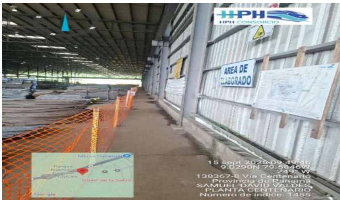
Figura 59. En inspección previa se solicitó la mejora de las mallas delimitación en ruta de evacuación la misma fue mejorada. (Autoría propia)
