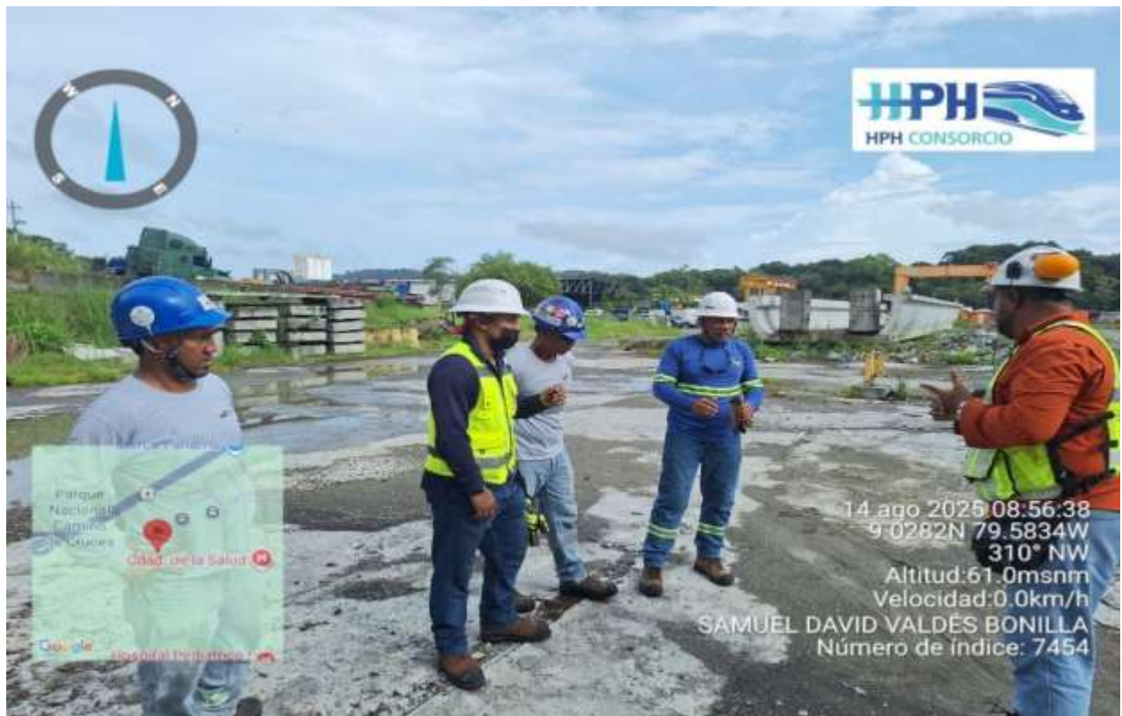
Figura 15. Se realiza entrenamiento a operadores de grúas para maniobra en patio de dovelas los mismos eran nuevos en la planta. (Autoría Propia)
