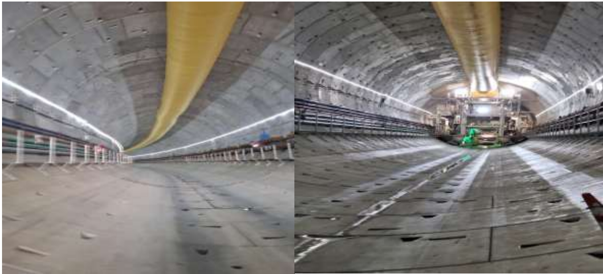
Figura 3 y 4. Fotos de túnel de línea 3 del metro de Panamá. (propia Autoría)
