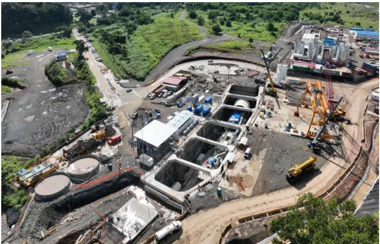
Figura 1. Área de túnel línea 3 Metro de Panamá (Elaboración Propia)
