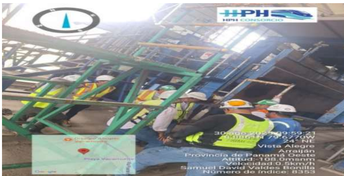
Figura 35. En inspección por aparte del cliente en las zonas de trabajo para verificar las implementaciones los protocolos de seguridad en nueva galera de INVERT BOX(Autoría propia)
