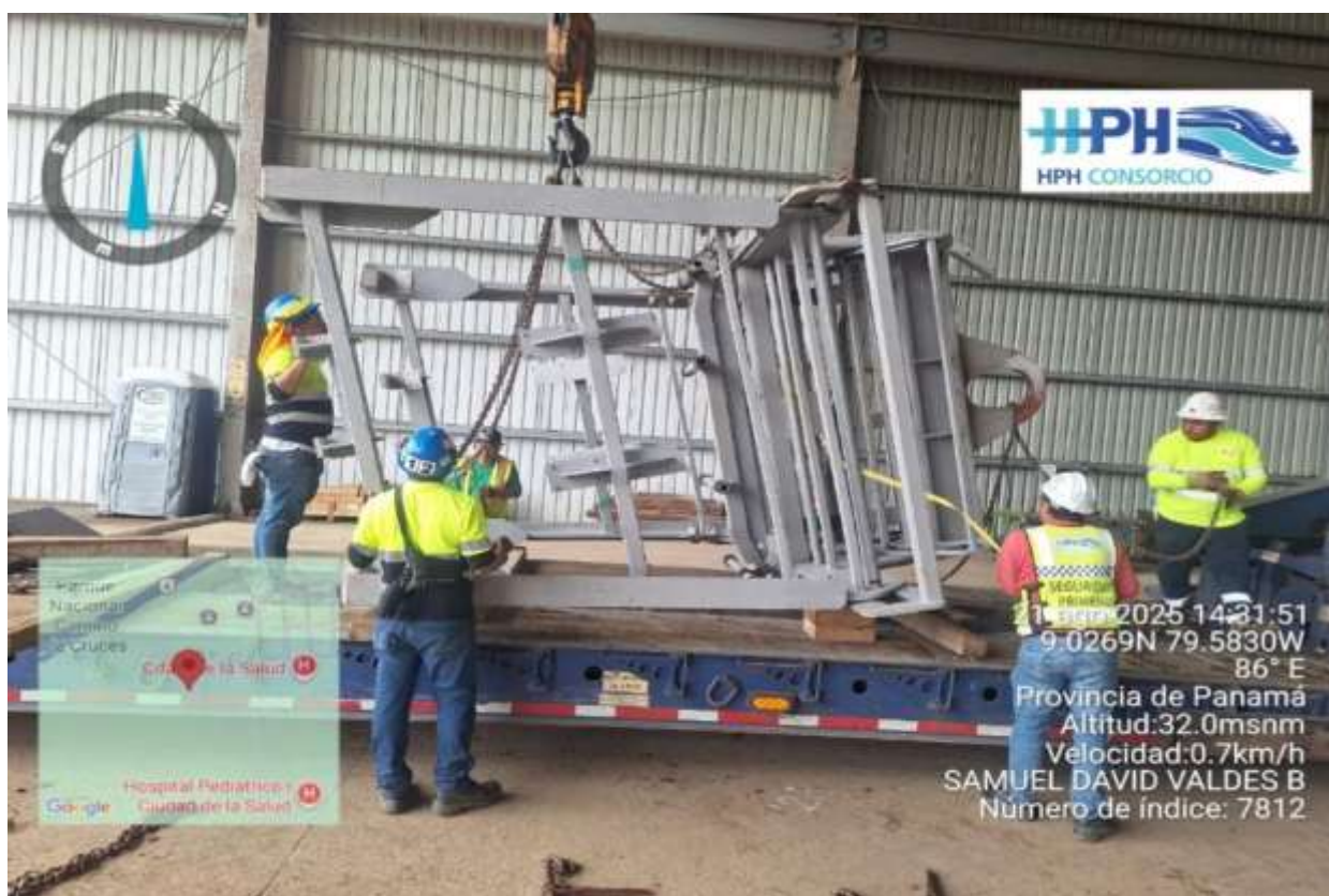
Figura 24. Se realiza liberación e inspección para traslados de piezas hacia zonas del proyecto las mismas cumpliendo con temas de altura, así como, longitud todo previo a su salida(Autoría propia)
