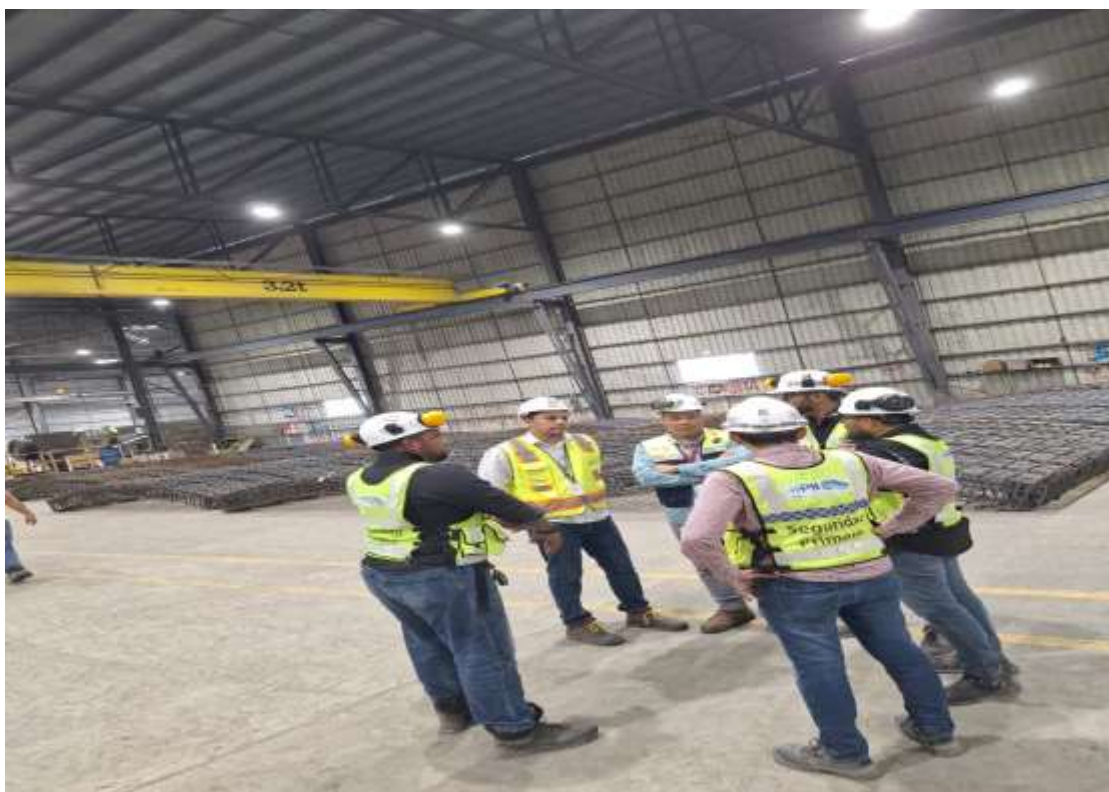
Figura 89. Reunión con el cliente sobre puntos de implementación de seguridad en obra. (Autoría propia)
